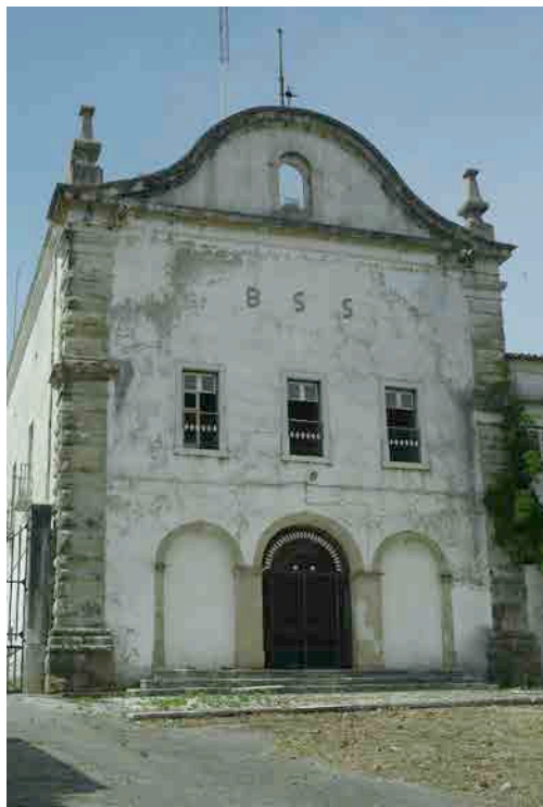
FIGURA 1 – Frontaria principal da antiga igreja do Convento de Brancanes
