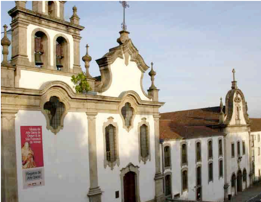
FIGURA 2 – Vinhais. Igreja, Casa do Despacho e Seminário de Nossa Senhora da Encarnação
